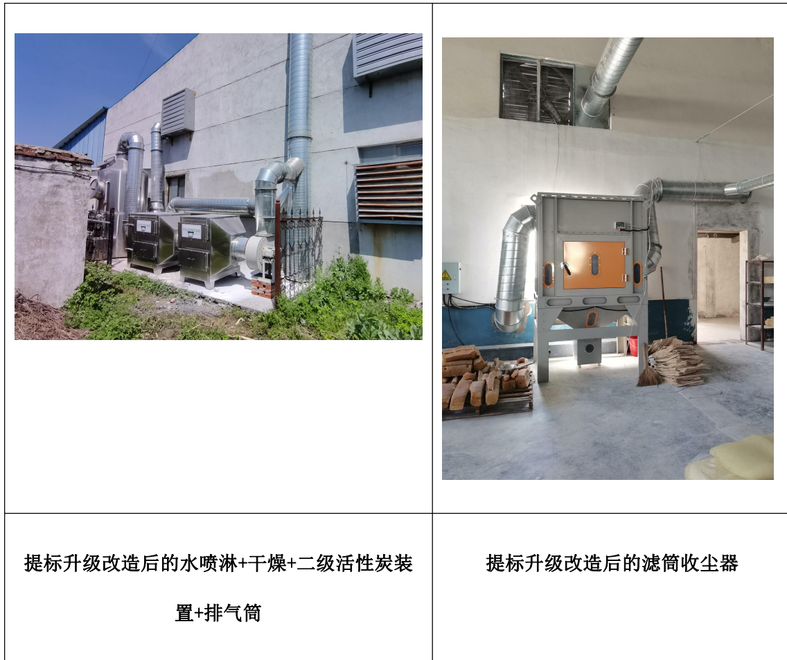
图 4 提标升级改造后的环保装置
